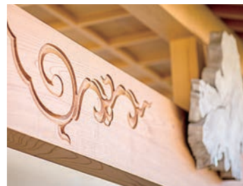
梁に刻まれた彫りは、改修前の彫刻を模したものの。その古い梁も師られている。
